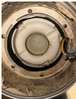
Plastsluk med klemring for membran
