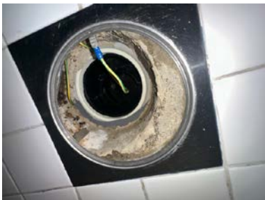
Sluk i plast, plassert i dusjnisje
