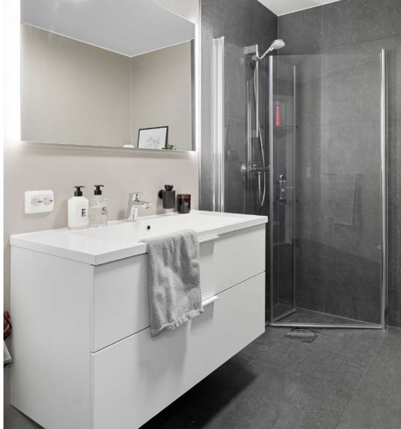
Malte veggflater og fliser på vegg i dusjområdet. Gulvet er flislagt med elektriske varmekabler.
