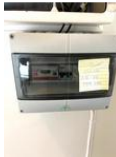
Undersentral med intern måler til hybel.
