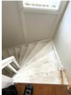
Trapp mellom 1 og 2 etasje
