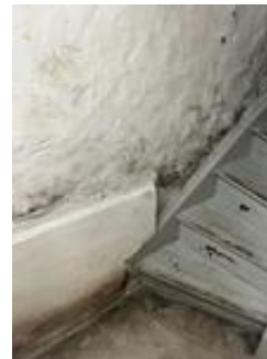
Råte i treverk i kjellervegg.
