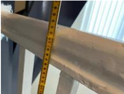
Rekkverkshøyde 73/74 cm.
