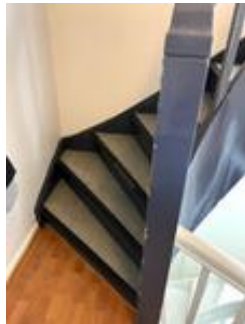
Rekkverkshøyde 73/74 cm.
