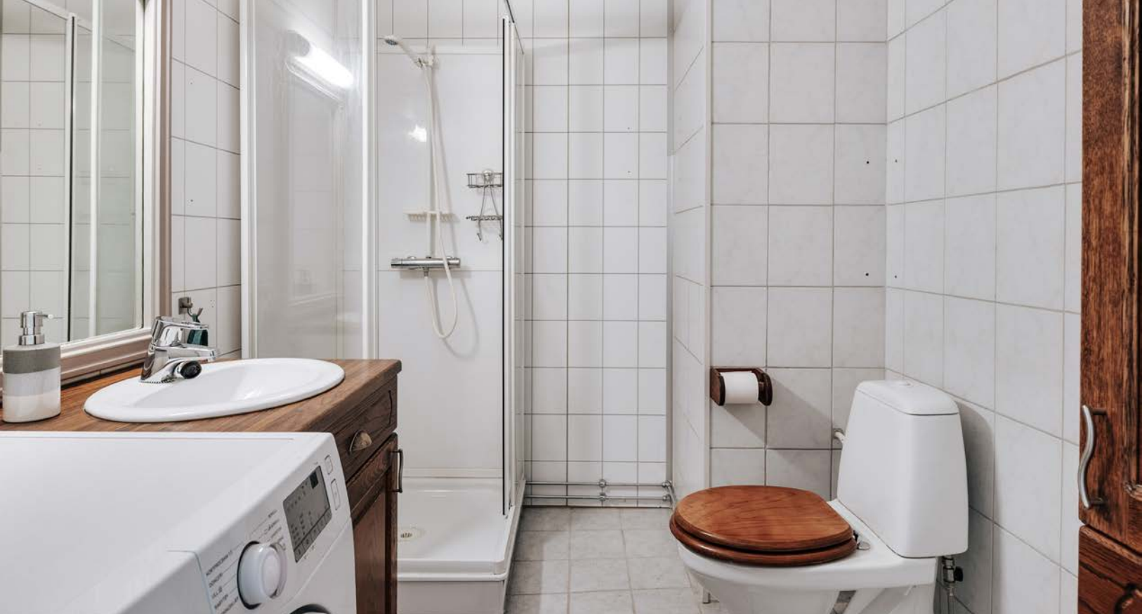
Bad med flislagt gulv og våtromsplater på veggene. Det er stråleovn på vegg over døra.
