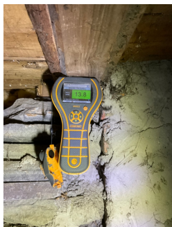
Måling i etasjeskille mellom kjeller og 1. etasje i eldste del.
