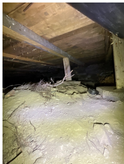
Stedvis provisorisk understøttelse av bjelkelaget.
