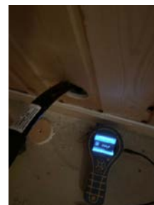
Fuktmåling i utforet kjellervegg.
