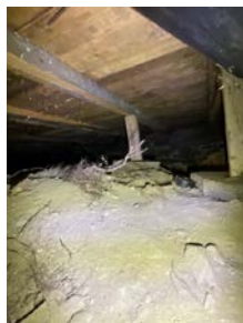
Stedvis provisorisk understøttelse av bjelkelaget.
