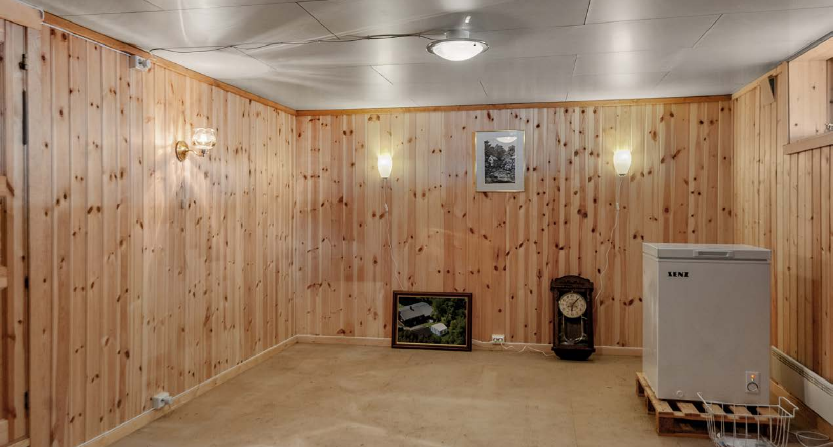
Innredet rom i kjeller ligger i tilbygget fra 1992
