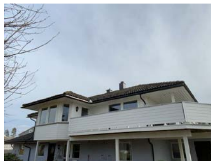
Besiktigelse av taktekke fra bakkeplan.
