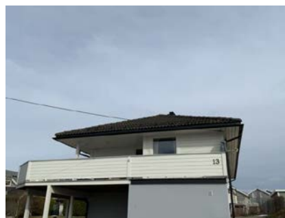
Besiktigelse av taktekke fra bakkeplan.
