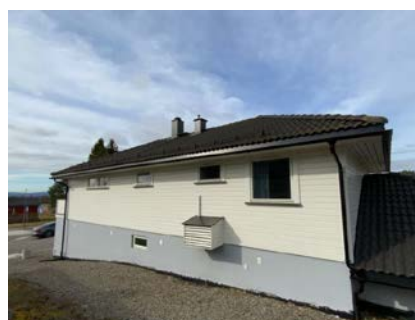
Besiktigelse av taktekke fra bakkeplan.
