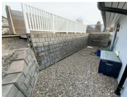
Besiktigelse av støttemur.
