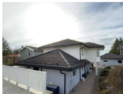
Besiktigelse av taktekke fra bakkeplan.
