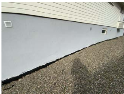
Kontroll av drenering/fuktsikring.
