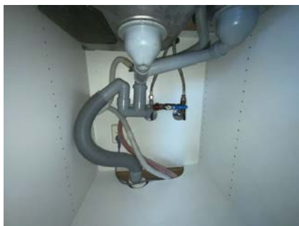
Besiktigelse av røropplegg.
