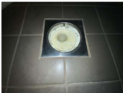
Kontroll av sluk.
