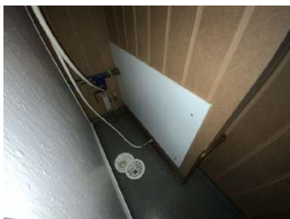
Besiktigelse av røropplegg.
