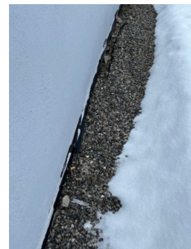
Kontroll av drenering/fuktsikring.
