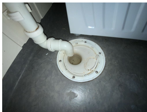
Kontroll av sluk.
