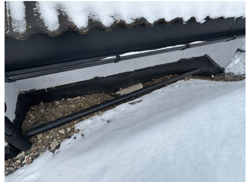
Kontroll av drenering/fuktsikring.
