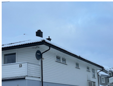
Besiktigelse av taktekke fra bakkeplan.
