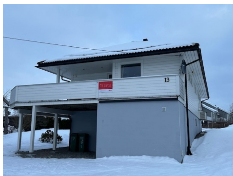
Besiktigelse av taktekke fra bakkeplan.
