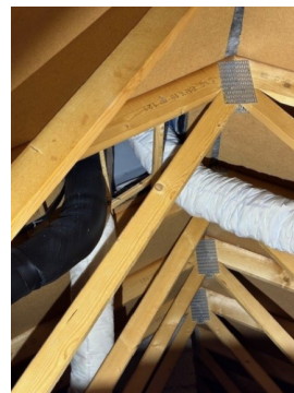
Kontroll rundt rørgjennomføringer.
