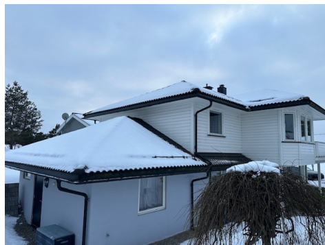
Besiktigelse av taktekke fra bakkeplan.
