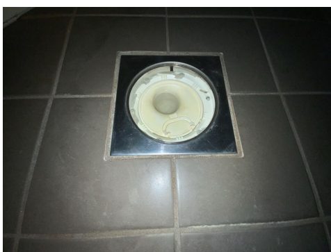
Kontroll av sluk.
