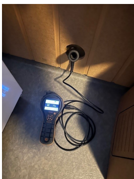
Utført hulltaking på rom under terreng.
