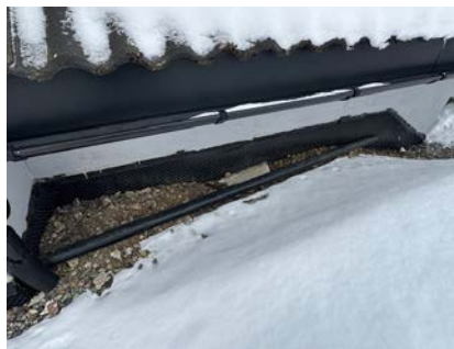
Kontroll av drenering/fuktsikring.
