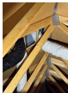
Kontroll rundt rørgjennomføringer.
