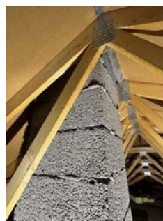
Kontroll rundt rørgjennomføringer.
