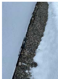
Kontroll av drenering/fuktsikring.
