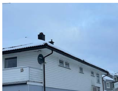
Besiktigelse av taktekke fra bakkeplan.
