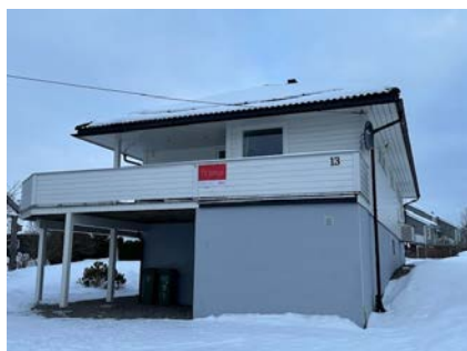
Besiktigelse av taktekke fra bakkeplan.
