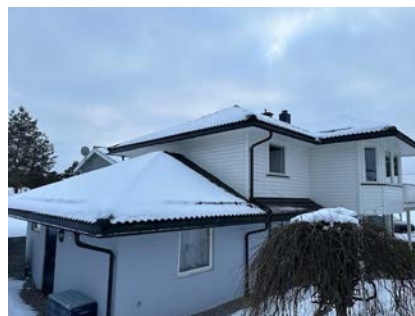
Besiktigelse av taktekke fra bakkeplan.
