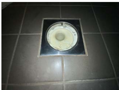
Kontroll av sluk.
