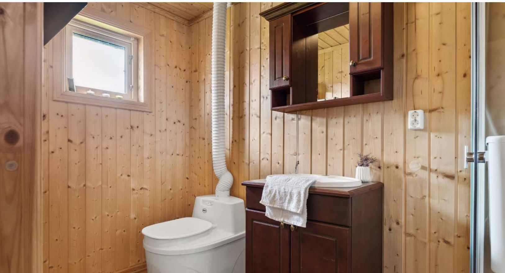
Her er det dusjkabinett, innredning med servant og lukket dosystem med egen lufting.
