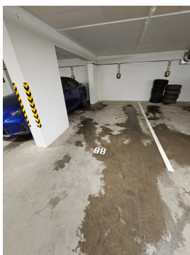
parkeringsplass med elbil-lader
