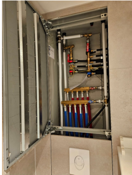
fordelerskap for forbruksvann og vannbåren varme
