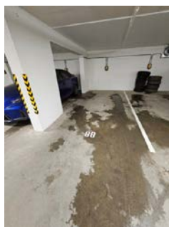
parkeringsplass med elbil-lader
