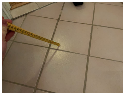
Bom/hullyd på fliser ved dør.
