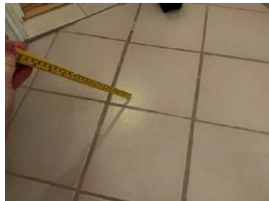
Bom/hulldyd på fliser ved dør.
