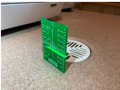
Motfall på gulv til sluk
