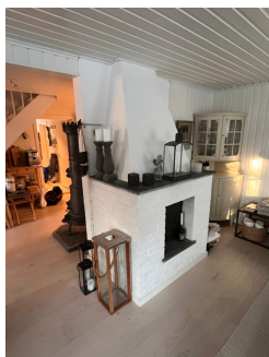
Det er ikke montert ubrennbar plate på gulv under peis.
