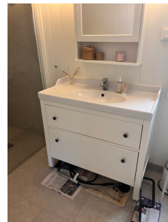
Malte mdf plater på vegg i våtsone.
