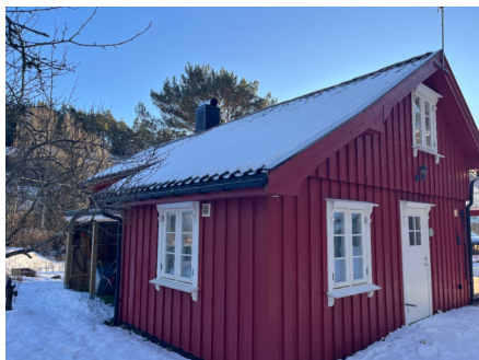
Kledning med kort avstand til terreng.
