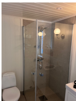
Malte mdf plater på vegg i våtsone.
