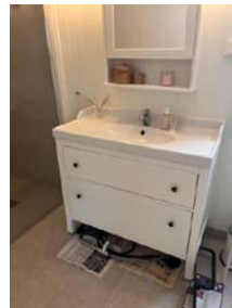
Malte mdf plater på vegg i våtzone.
