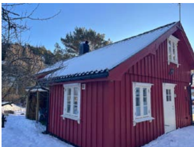
Kledning med kort avstand til terreng.
