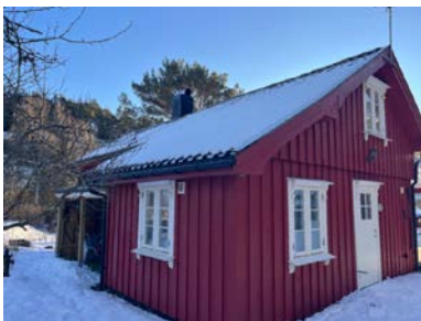
Kledning med kort avstand til terreng.
