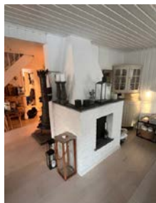
Det er ikke montert ubrennbar plate på gulv under peis.
