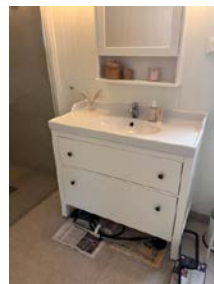
Malte mdf plater på vegg i våtzone.
