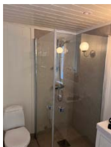
Malte mdf plater på vegg i våtzone.
