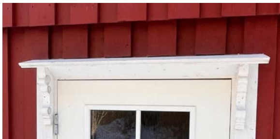
Ikke spalte mellom vannbrett og kledning, ikke montert beslag på vannbrett.
