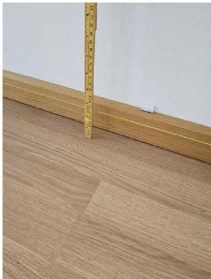
Bilde viser måling av etasjeskiller.
