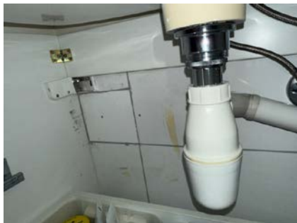
Ufagmessig tetting av tidligere hull.
