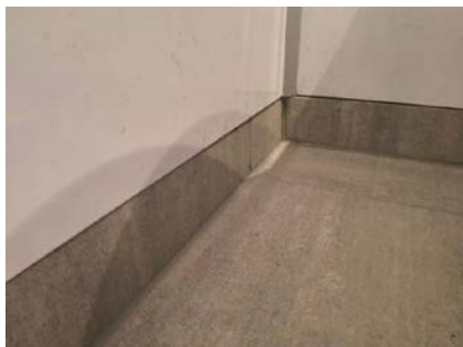
Feil montering av baderomsplater.
