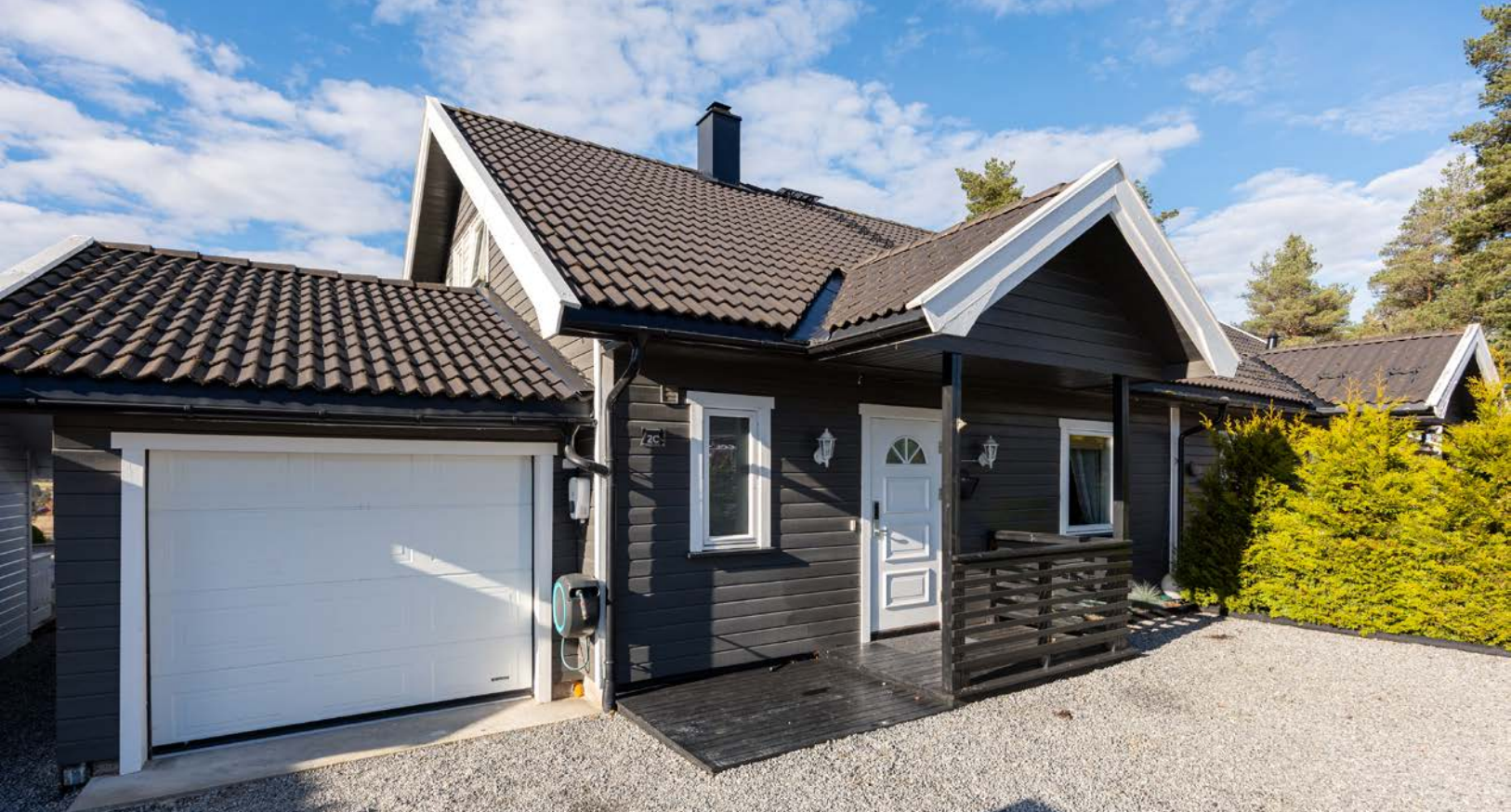
Eiendommen har en smal enkelgarasje med motorisert leddport, som opprinnelig var en carport.
