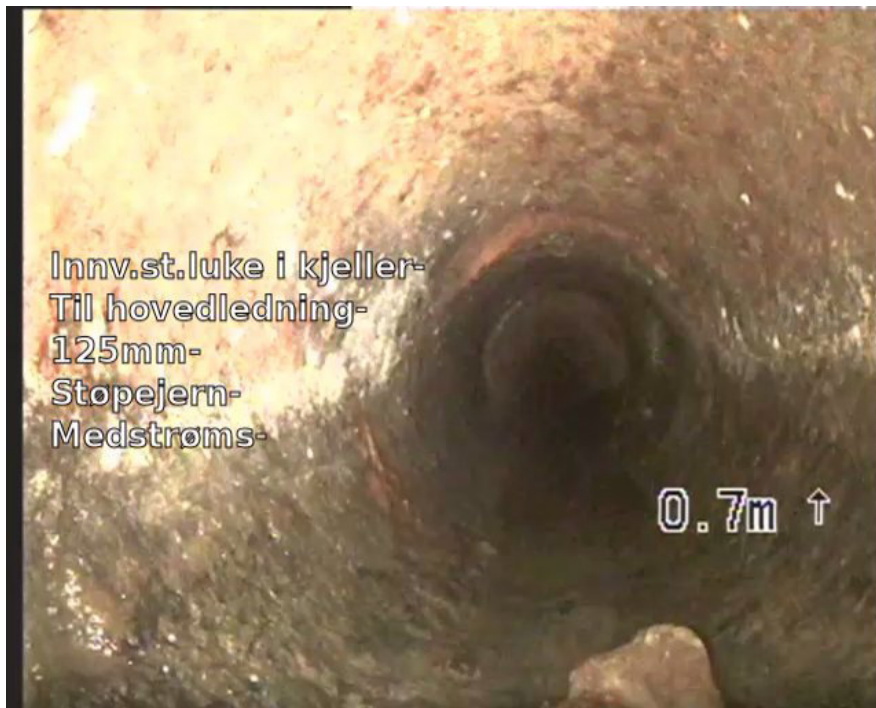
UB 0,70m Rust, fett og sedimenter, Gradering 2, Type: Sedimenter, K1 6. Liten knoll som sitter fast
