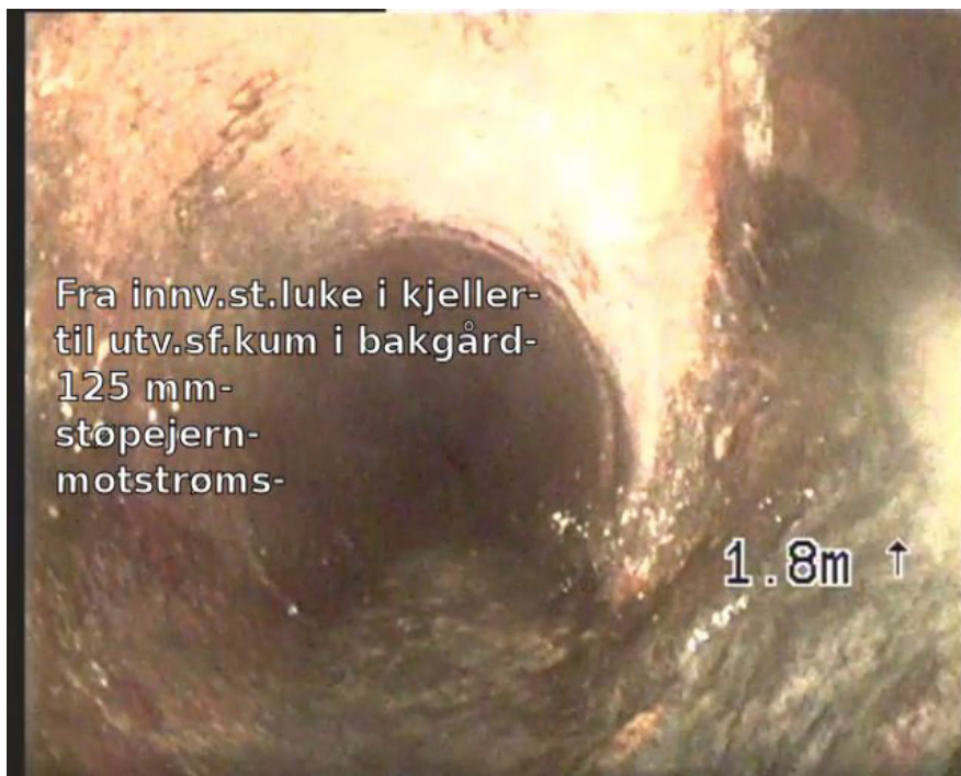
TK 1,80m Tilkopling, Type: Prefabrikeret, K13
