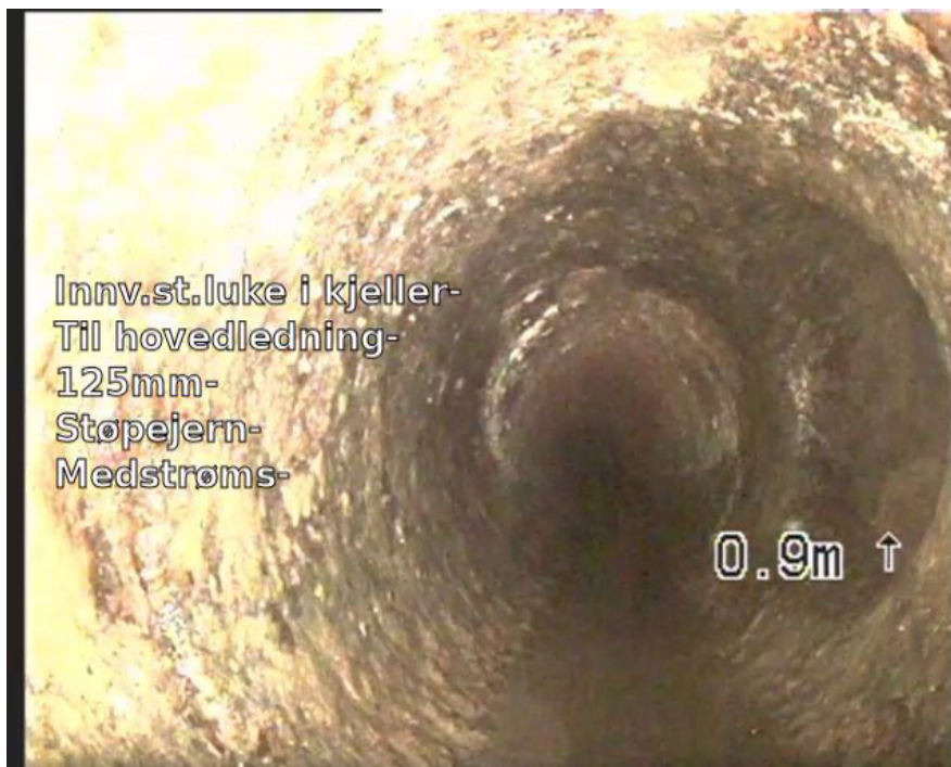
TK 0,90m Tilkopling, Type: Prefabriert, K13
