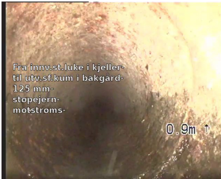
UB 0,90m Rust, fett og sedimenter, Gradering 1, Type: Utfelling, K14-8
