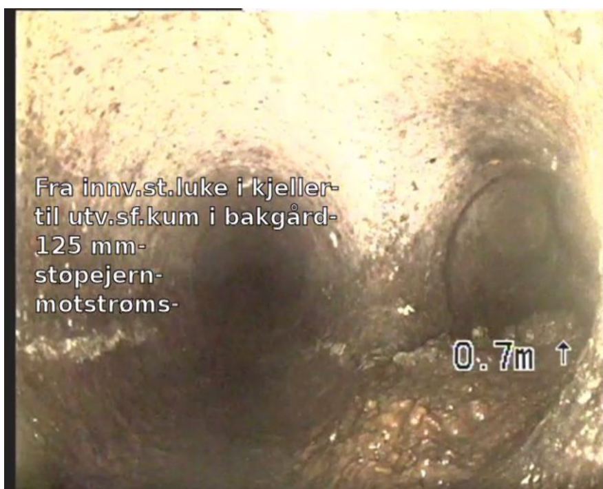
TK 0,80m Tilkopling, Type: Prefabriert, Kl 3
