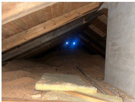
Oversiktsbilde fra loft
