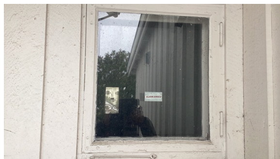
Vindu med enkelt glass og vareramme.
