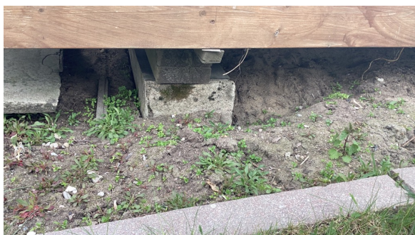
Enkel fundamentering av veranda.
