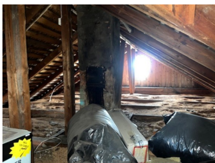
Oversiktsbilde fra loft.
