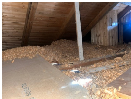
Oversiktsbilde fra loft.
