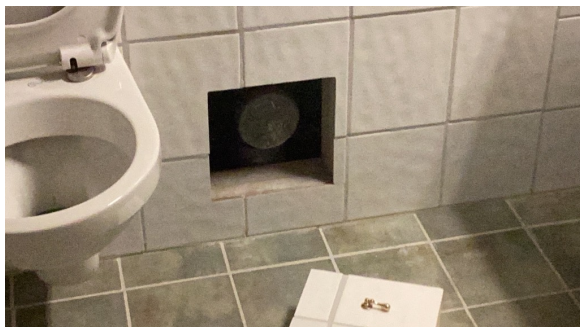
Stakepunkt på bad i 1. etasje.
