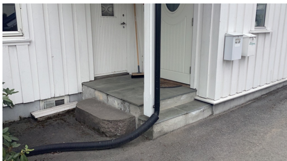
Trapp på bakside.
