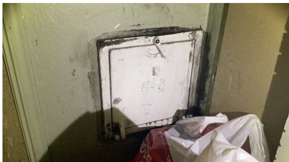
Sotluke i gang
