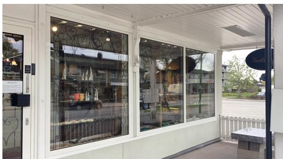
Fasadefelt med panserglass.
