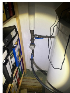
Hovedinntak til eiendommen med hovedstoppekran og felles vannmåler i kjeller.
