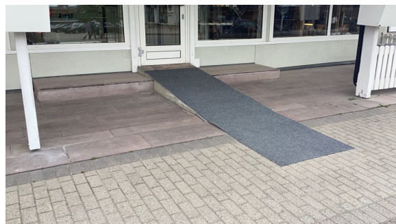
Rampe ved hovedinngang.
