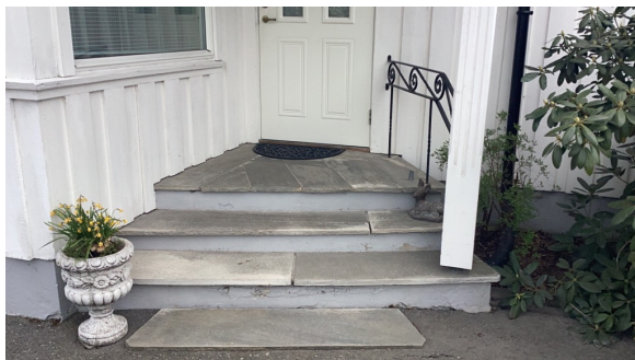
Trapp ved hovedentre.
