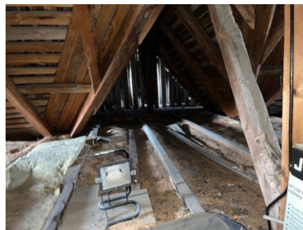
Oversiktsbilde fra loft
