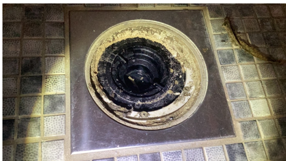
Sluk av plast i dusj.
