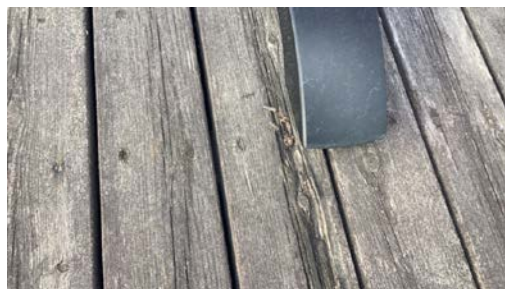
Eksempel på råte i gulvbord.
