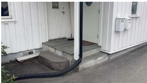
Trapp på bakside.
