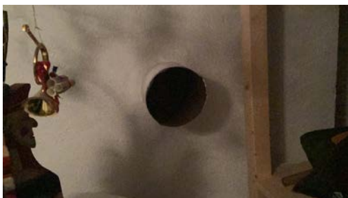
Åpent røykrør i kjeller.
