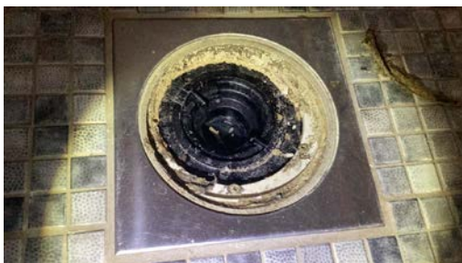
Sluk av plast i dusj.
