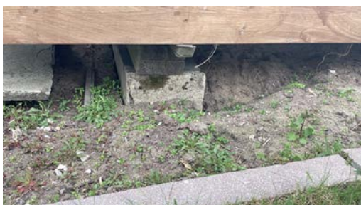
Enkel fundamentering av veranda.
