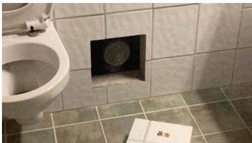
Stakepunkt på bad i 1. etasje.
