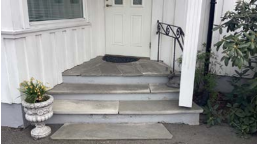
Trapp ved hovedentre.
