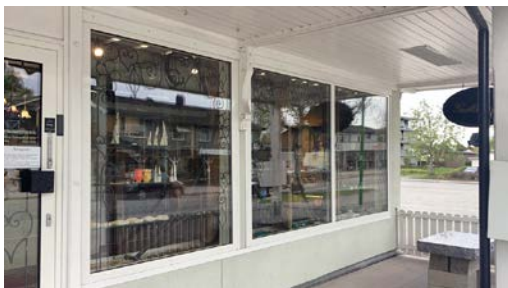
Fasadefelt med panserglass.
