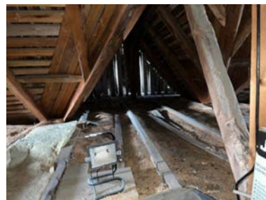
Oversiktsbilde fra loft
