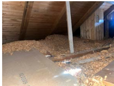
Oversiktsbilde fra loft.
