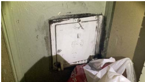
Sotluke i gang
