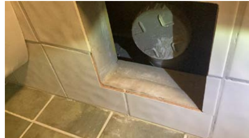
Det kan ses bruk av membran ved inspeksjonsluke.
