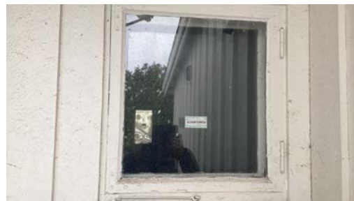
Vindu med enkelt glass og vareramme.
