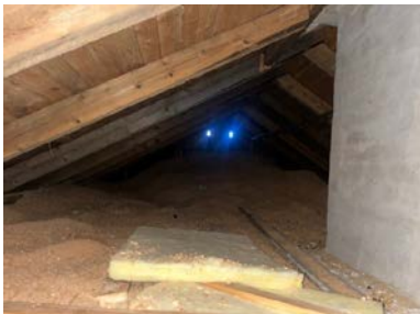
Oversiktsbilde fra loft
