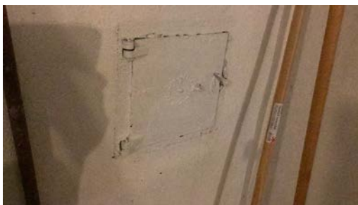
Sotluke i kjeller.
