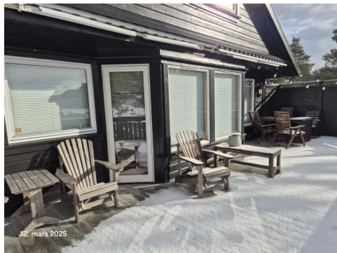
Noe av terrassebordene vises i bildet.
