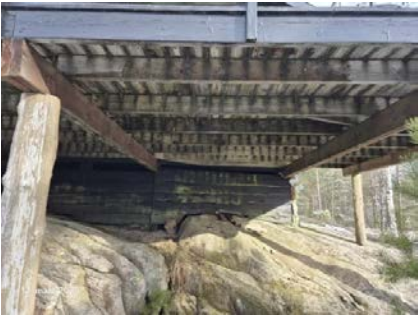
Bilde tatt fra under terrassen. Grønne og normal slitasje.
