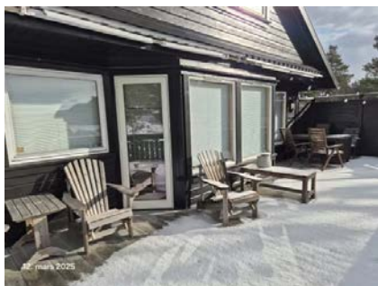
Noe av terrassebordene vises i bildet.
