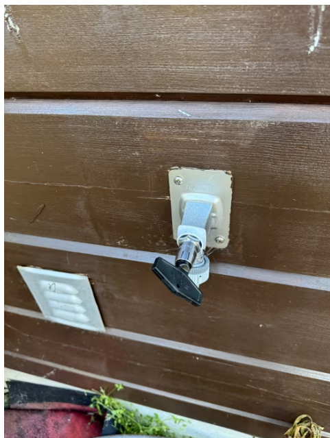
Det er etablert utekran.
