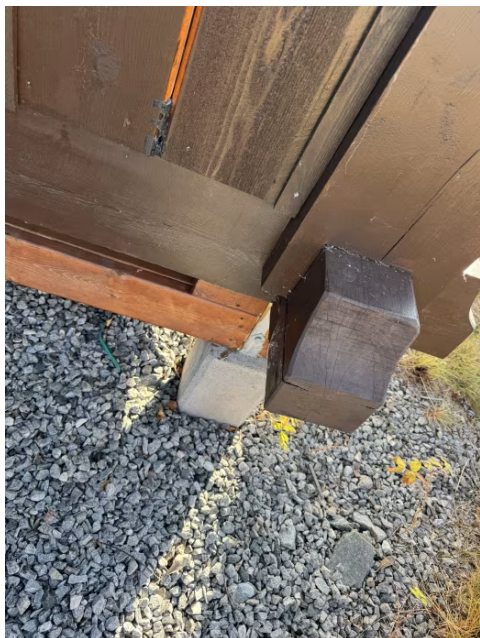
Utebod fundamentert på betongsøyler.
