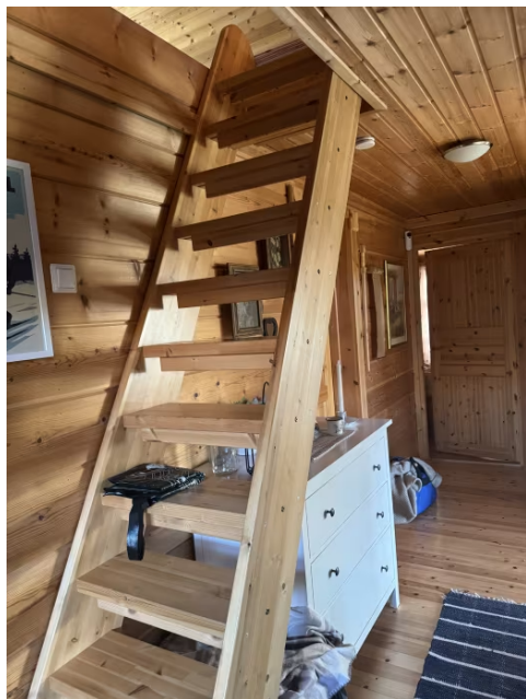
Bratt trapp uten rekkverk.
