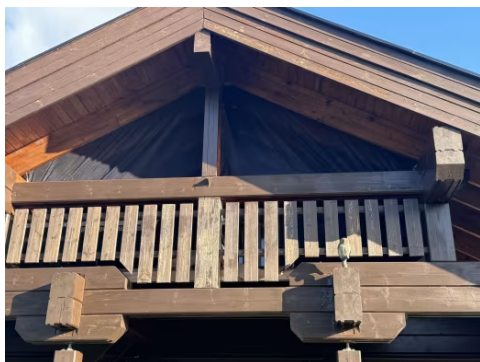
Lavt rekkverk i 2. etg.
