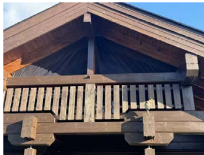
Lavt rekkverk i 2. etg.
