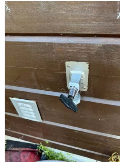
Det er etablert utekran.
