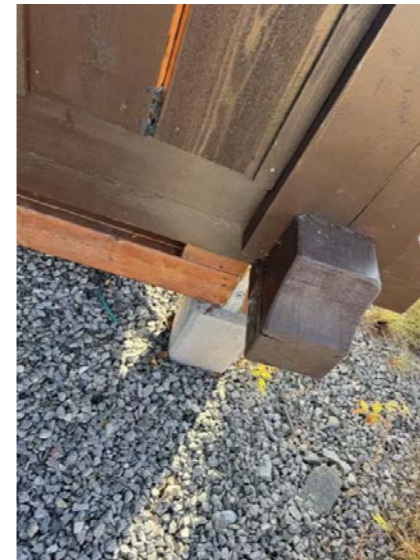
Utebod fundamentert på betongsøyler.
