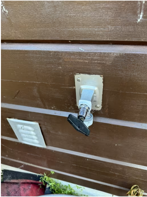
Det er etablert utekran.
