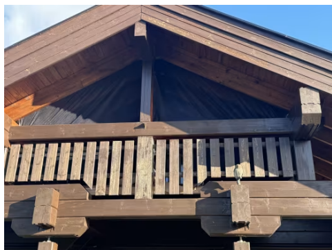
Lavt rekkverk i 2. etg.
