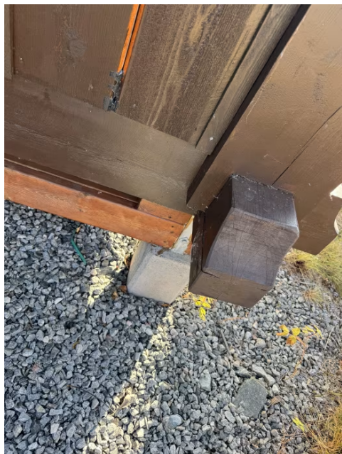
Utebod fundamentert på betongsøyler.
