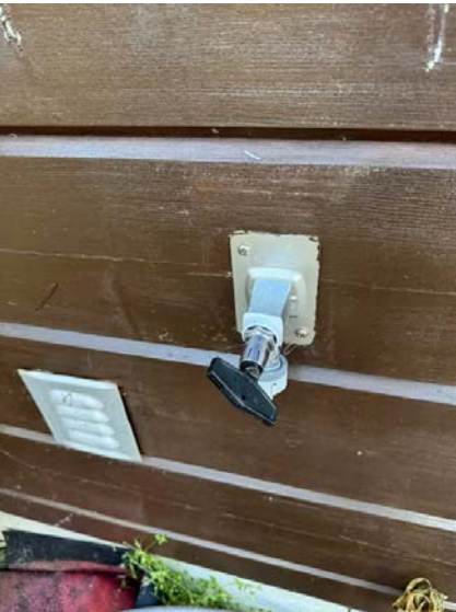
Det er etablert utekran.
