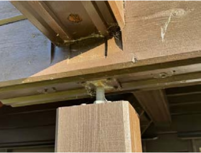
Hele takkonstruksjonen kan høydejusteres i forhold til tømmer/laft ved synk.
