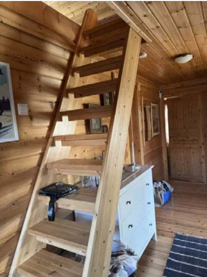
Bratt trapp uten rekkverk.
