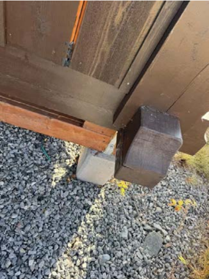
Utebod fundamentert på betongsøyler.
