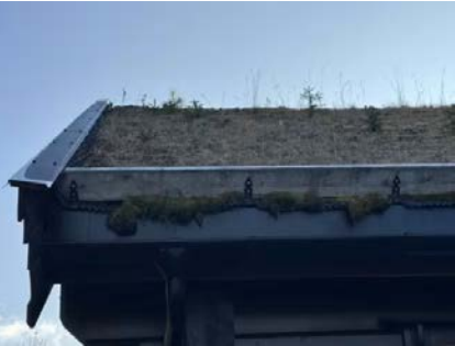
Tak tekket med torv. Inspisert kun fra bakken. Noe vedlikehold må påregnes.
