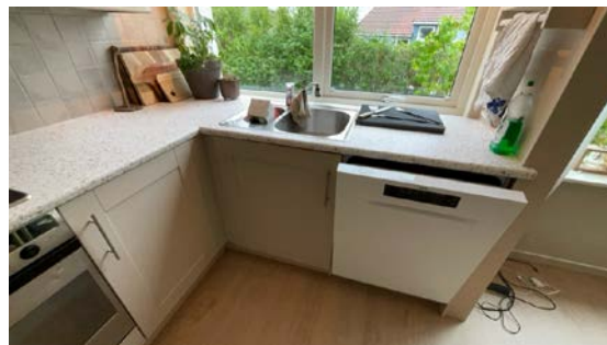
Enkelte oppsvellinger etter vannsøl rundt vask.
