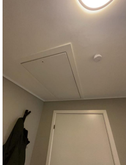
Isolert loftsluke med stige i gang.
