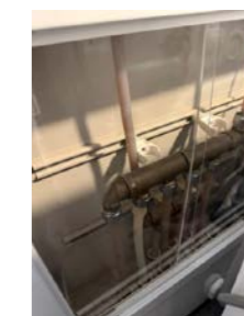
Selger har montert sprutplate i vannfordelingsskap etter befaringen for å ivareta vannsikkerheten.
