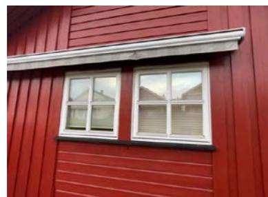
Vinduer på soverom og bad/vaskerom
