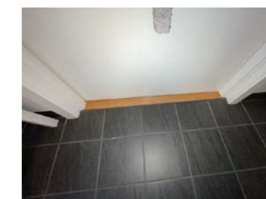
Standard dørterskel uten tilluft
