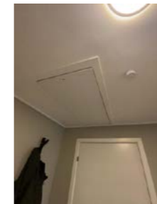
Isolert loftsluke med stige i gang.
