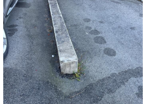
Støttemur ved biloppstillingsplass.
