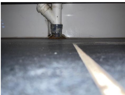
Rørgjennomføring i gulv under vaskeservant.
