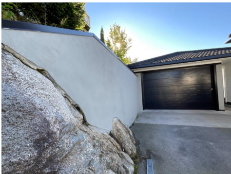
Støttemur ved garasje
