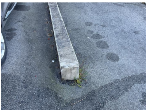
Støttemur ved biloppstillingsplass.
