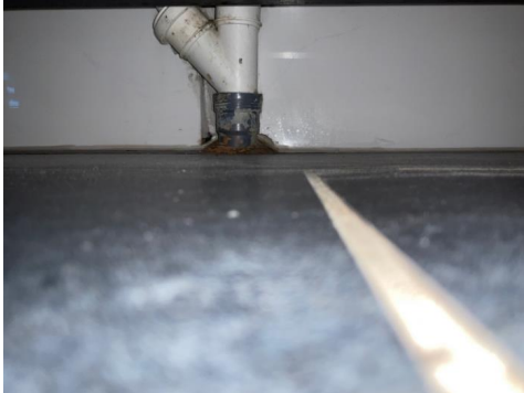
Rørgjennomføring i gulv under vaskeservant.
