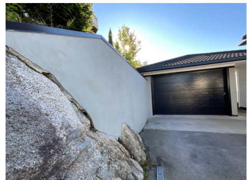
Støttemur ved garasje
