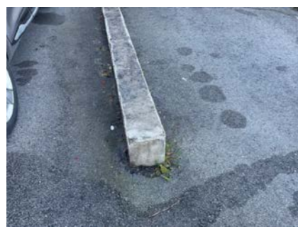
Støttemur ved biloppstillingsplass.
