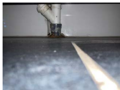
Rørgjennomføring i gulv under vaskeservant.
