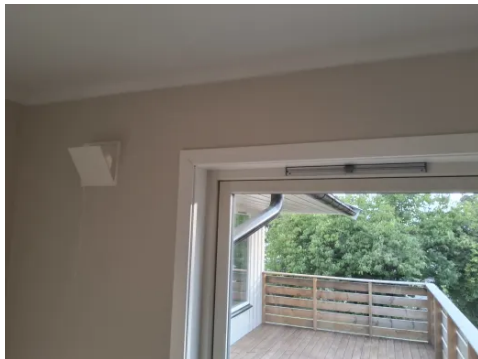
Naturlig ventilasjon med klaffventiler på yttervegg og spalteventiler i vinduer.
