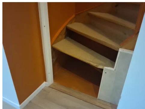
Trappen mangler nederste trinn.
