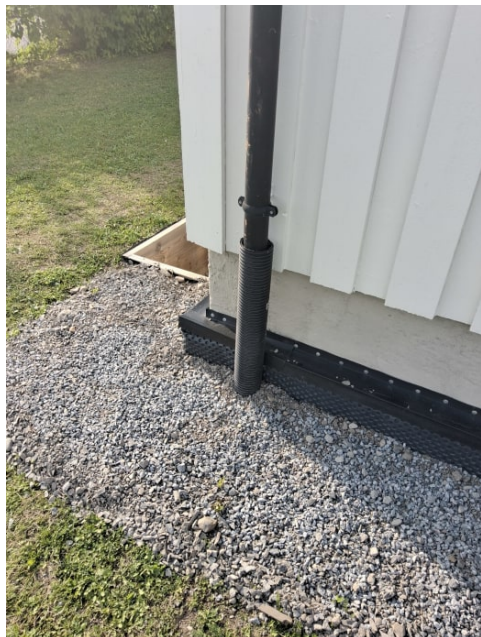
Drenering ble fornyet i 2020.
