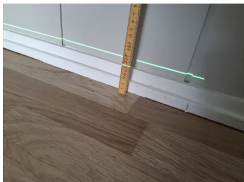
Etasjeskiller er kontrollert med nivelleringslaser.
