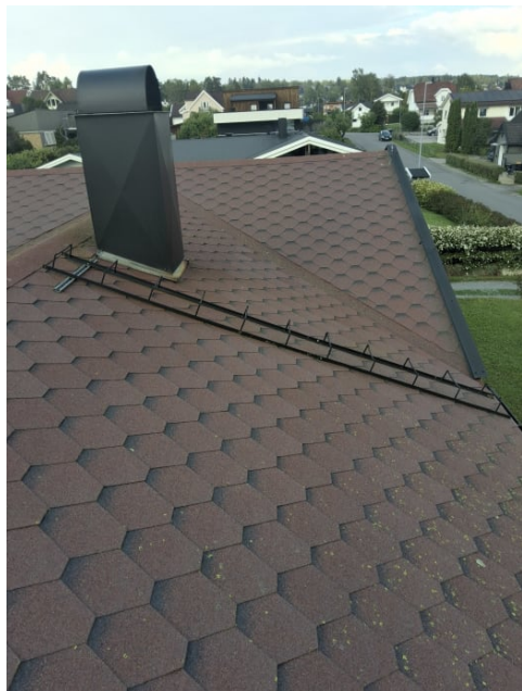
Det er fastmontert takstige til pipe.
