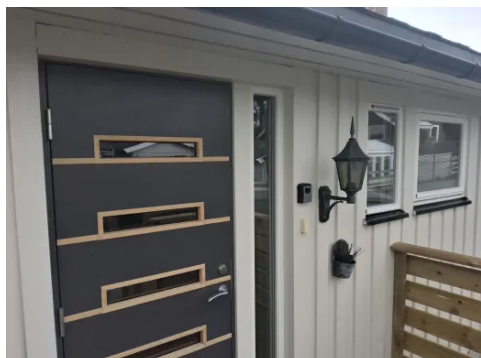
Boligen har vinduer og dører fra 2020-2022.
