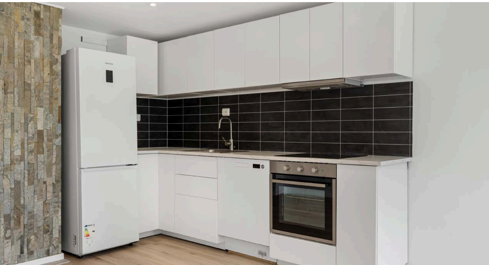
Kjøkkenet har innredning fra IKEA og består av over- og underskap med hvite, glatte fronter. Laminert benkeplate med nedfelt oppvaskum med ett-greps blandebatteri. I benkeryggen er det påsatt laminert plate.
