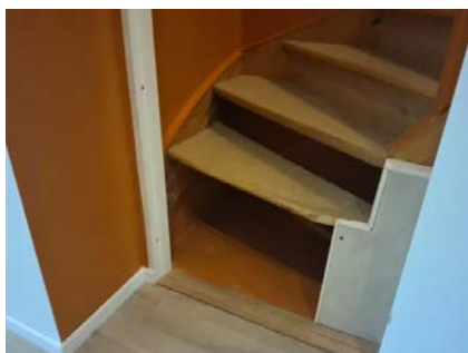
Trappen mangler nederste trinn.
