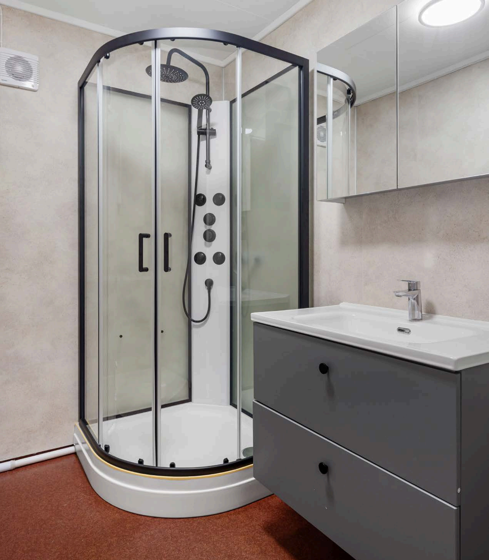
Eldre bad med belegg på gulvet og baderomsplater på veggene. Badet er oppgradert med ny innredning og dusjkabinett i 2025.
