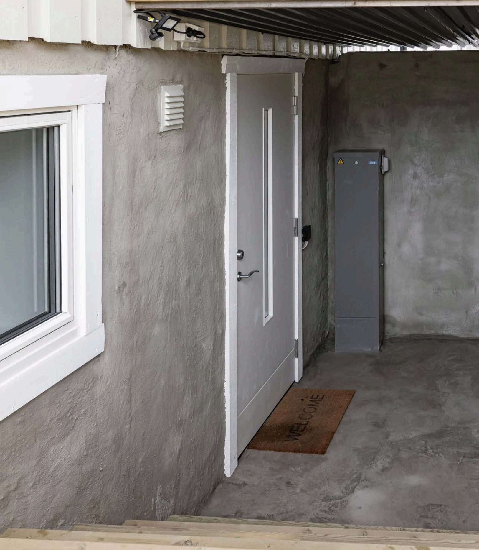
Nedgang og inngang til kjeller.
