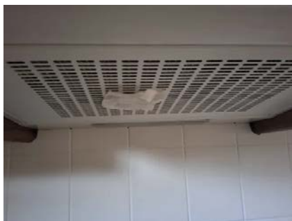
Avtrekkseffekt er testet med papir.
