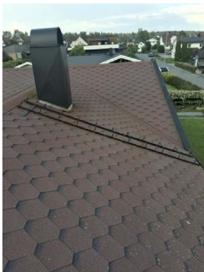
Det er fastmontert takstige til pipe.
