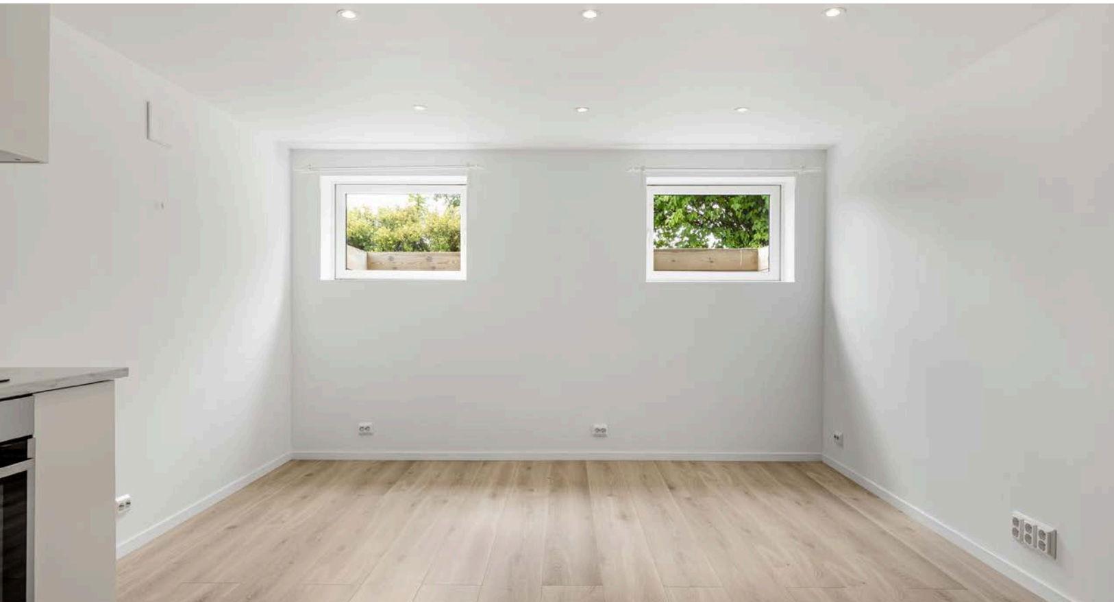
Gulvet har laminat og i taket er det god belysning med downlights.
