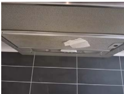
Avtrekkseffekt er testet med papir.
