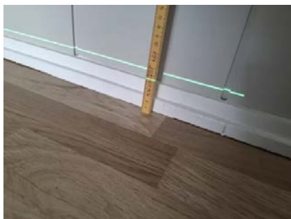
Etasjeskiller er kontrollert med nivelleringslaser.
