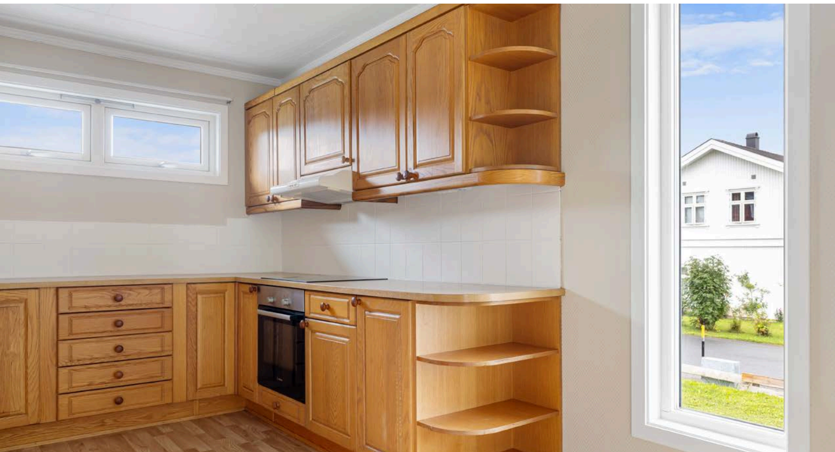
Laminerte benkeplater med nedfelt oppvaskkum. I benkeryggen er det påsatt fliser.
