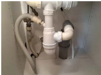
Boligen har synlige avløpsrør av plast.
