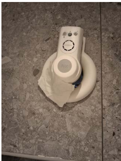
Avtrekkseffekten er testet med papir.
