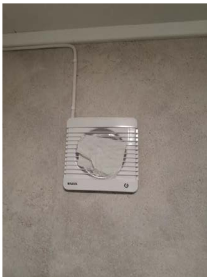
Avtrekkseffekt er testet med papir.
