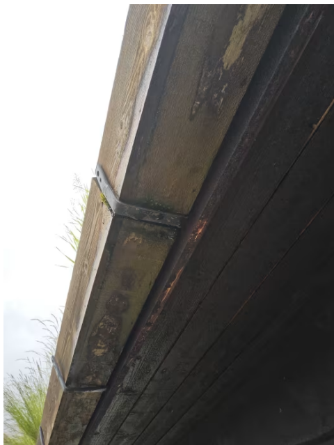
Bilde viser takrenne.
