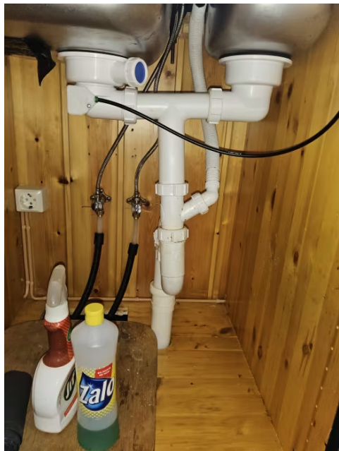
Bilde viser avløpsrør under oppvaskkum på kjøkken.
