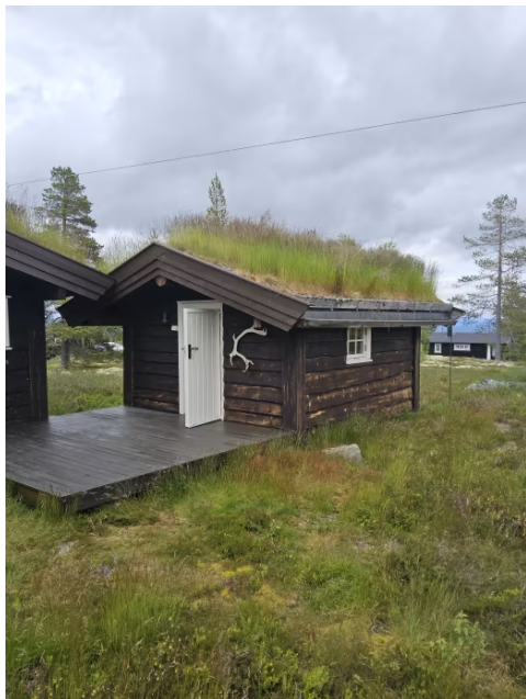
Bilde viser bod.
