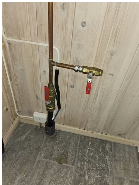
Bilde viser hovedstoppekran.
