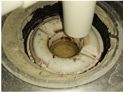
Bilde viser sluk på bad.
