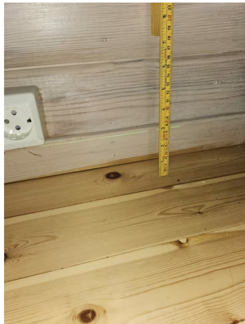
Bilde viser måling av etasjeskiller.
