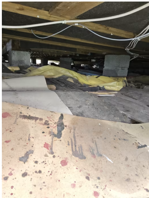
Bilde viser krypkjeller.
