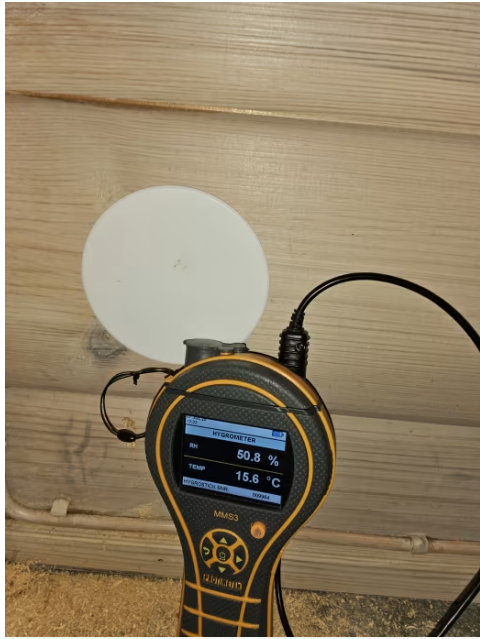
Bilde viser fuktmåling.
