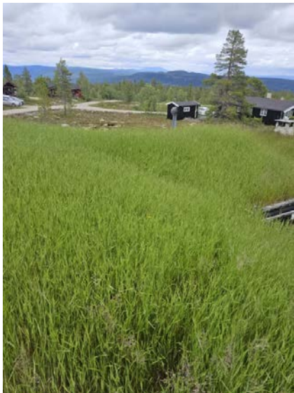
Bilde viser torvtak.
