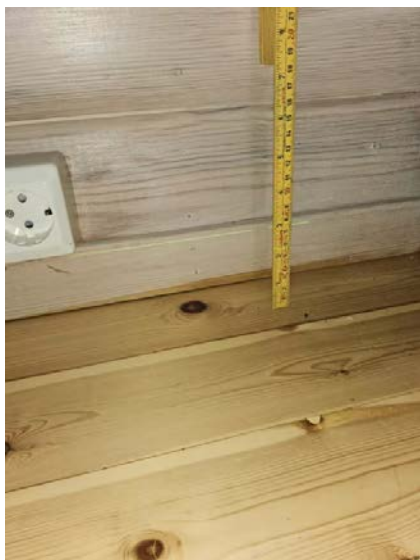
Bilde viser måling av etasjeskiller.
