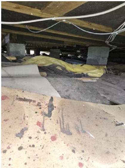
Bilde viser krypkjeller.
