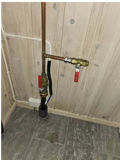
Bilde viser hovedstoppekran.
