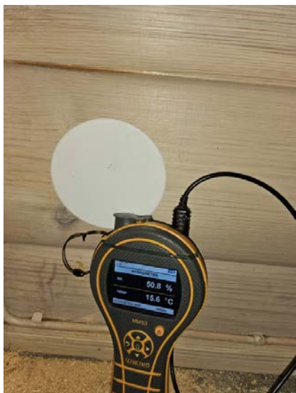
Bilde viser fuktmåling.
