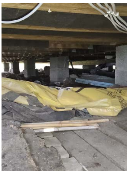
Bilde viser grunnmursblokker.
