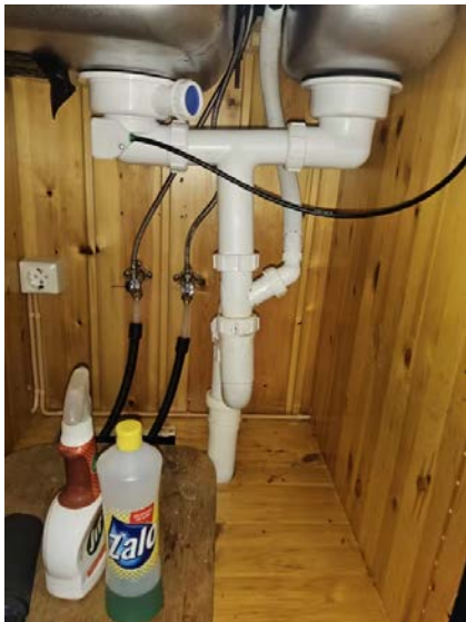
Bilde viser avløpsrør under oppvaskkum på kjøkken.
