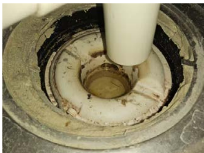
Bilde viser sluk på bad.
