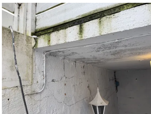
Riss/sprekk og kalk/salt utslag i støttemur indikerer tidligere transport av fukt.
