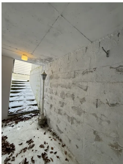
Riss/sprekk og kalk/salt utslag i støttemur indikerer tidligere transport av fukt.
