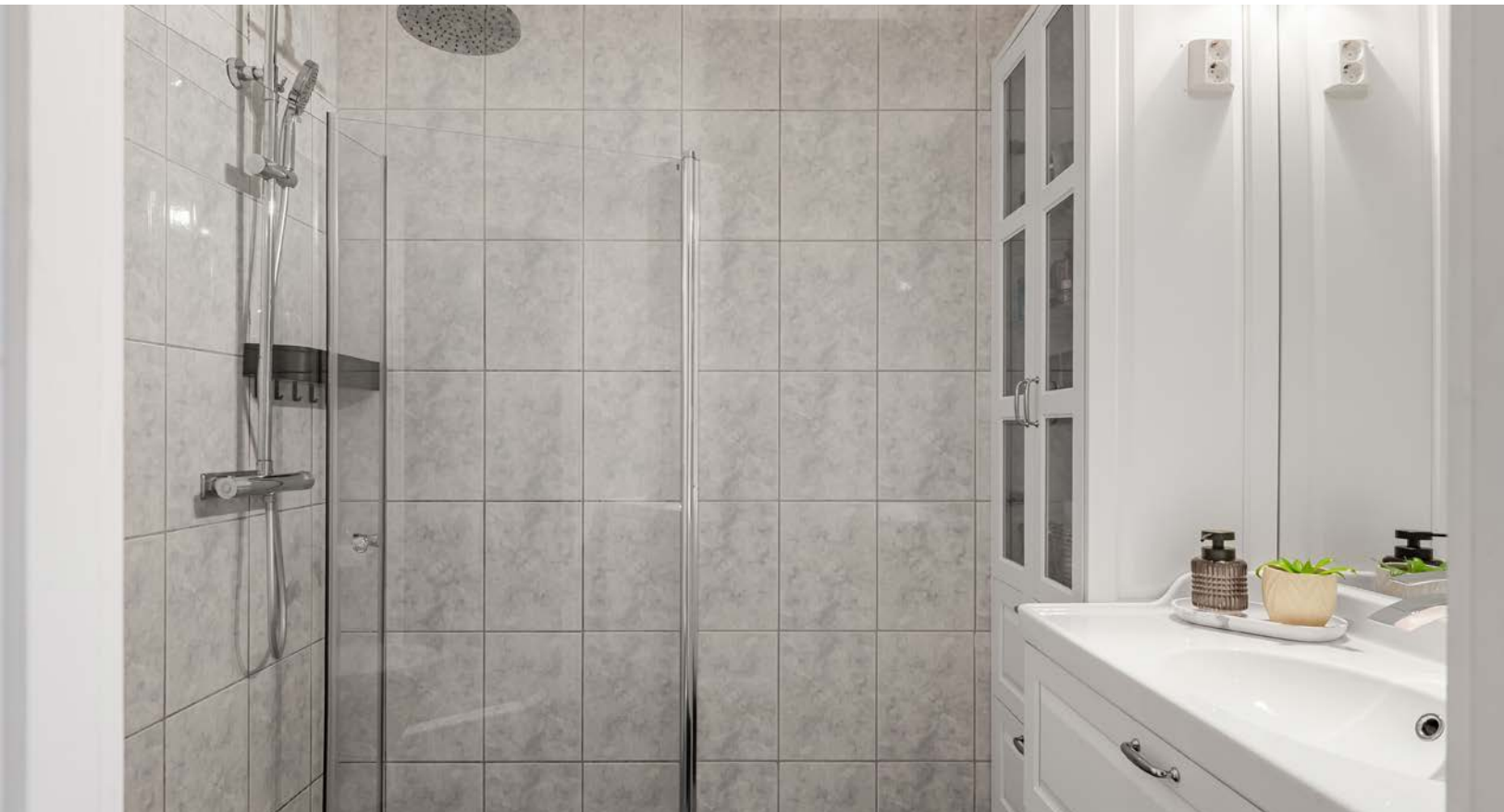
Bad i 1. etasje med overflater, installasjoner og komponenter fra 2003. Baderommet har fliser på gulv og vegger, elektriske varmekabler og elektrisk styrt vifte.
