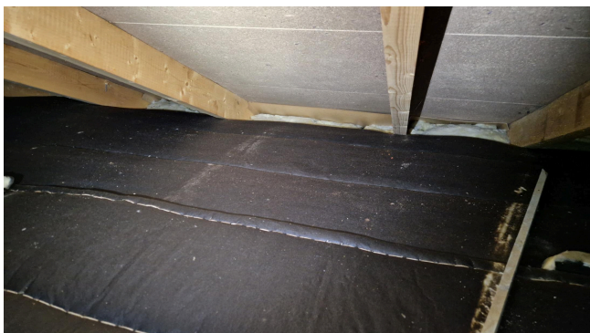
Loft – isolasjon mot yttervegg: Intakt isolasjon og vindsperre, ingen synlige fukttegn.
