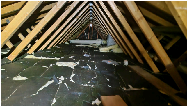
Loft – oversiktsbilde: Kaldloft med plassbygde takstoler, mineralullisolasjon og vindsperre.
