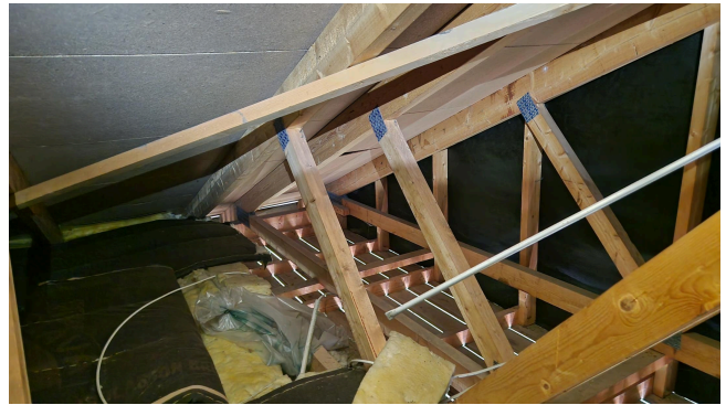
Loft – raftområde: God lifting ved raft, isolasjon og undertak i tilfredsstillende stand.
