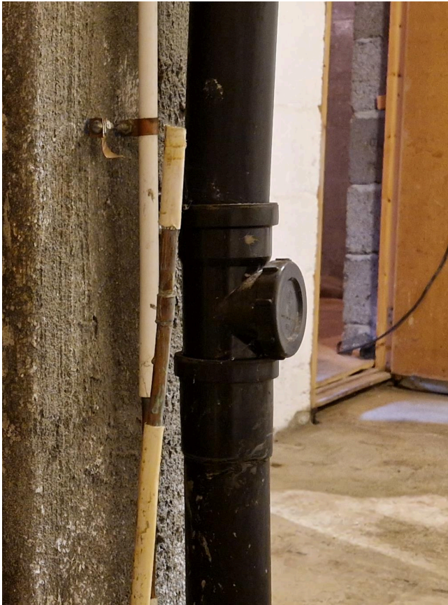
Avløpsrør med stakeluke ved siden av pipa i kjelleren.
