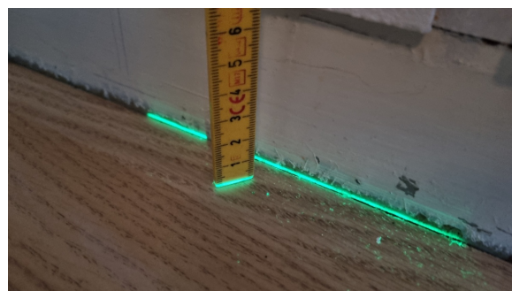
Kontroll av planavvik.
