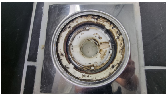
Plastsluk av nyere dato.
