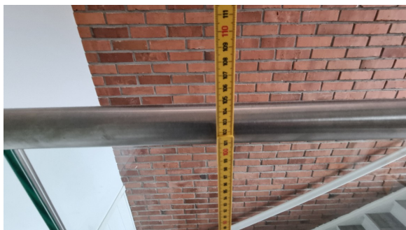
Kontroll av høyde på glassrekkverk.
