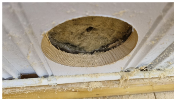
Det er benyttet dampspærre på innsiden av vegger under terreng.
