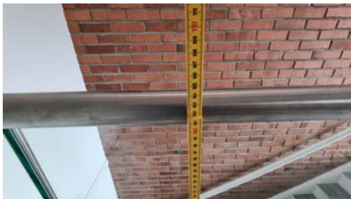
Kontroll av høyde på glassrekkverk.
