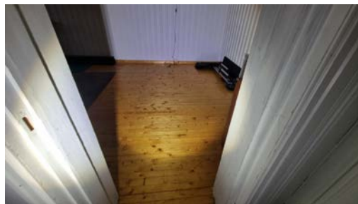
Tilfarergulv med ukjent konstruksjonsoppbygging.
