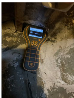
Fuktmåling i etasjeskille eldste del.
