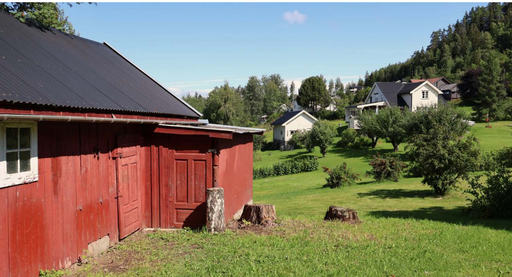
Eldre uthus på ca. 60m 2 med lav standard. Bygningene på eiendommen bærer preg av manglende vedlikehold og anses som et oppussingsobjekt.
