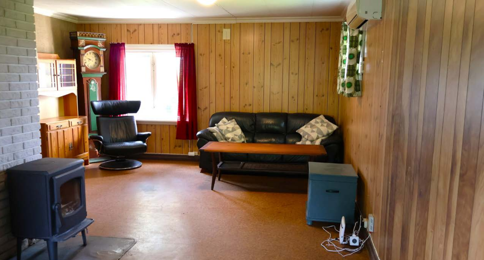
Stue med vedovn og luft-til-luft varmepumpe.
